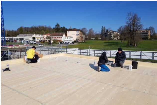
TS3 beim TS3-Verguss des Vordachs
