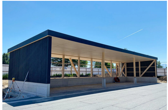
Überdachung des Containerhauses
