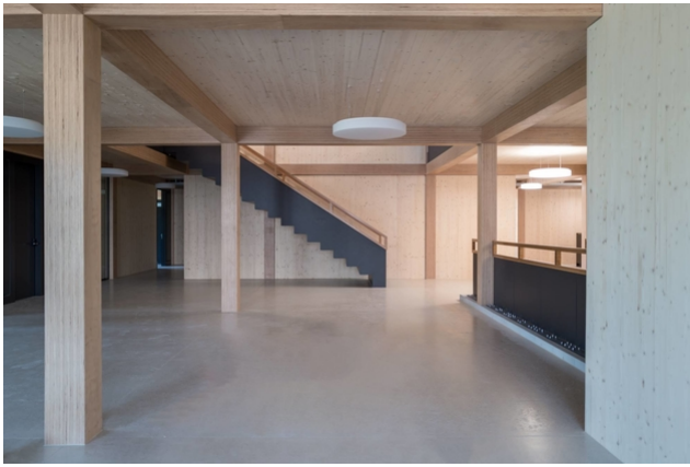
Innenansicht mit Buchenstützen
