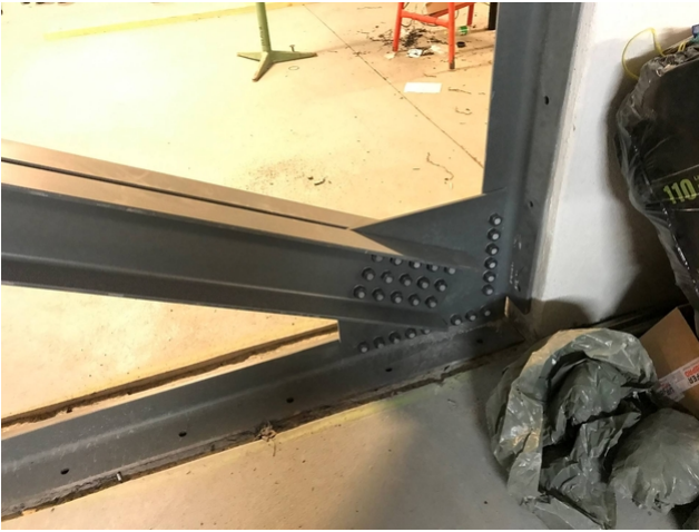
Stahlkreuz zur Erdbebenertüchtigung
