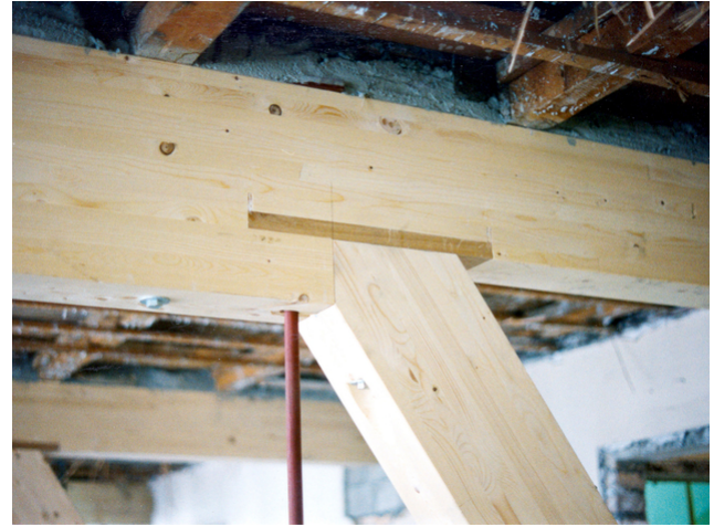
Querdruckbewehrung mit Hartholz
