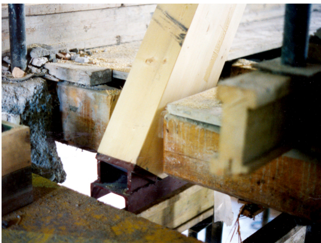
UNP-Träger, Endstütze Traverse
