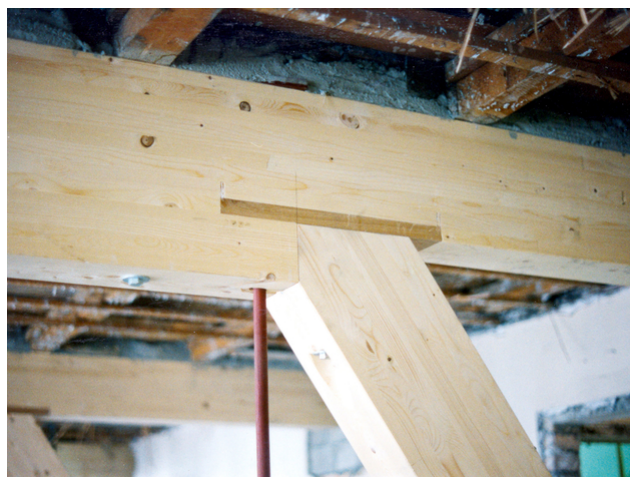
Querdruckbewehrung mit Hartholz
