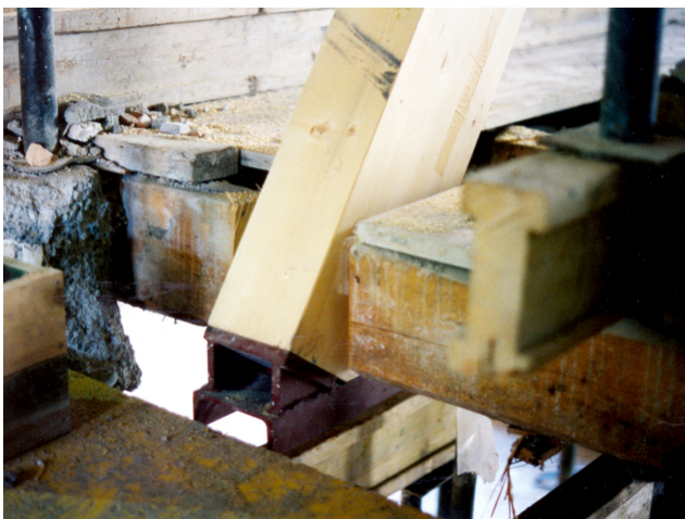
UNP-Träger, Endstütze Traverse
