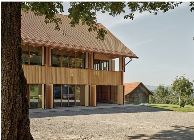
Stahlteile Fehlanzeige: Detaillösung mit Buchennägeln
