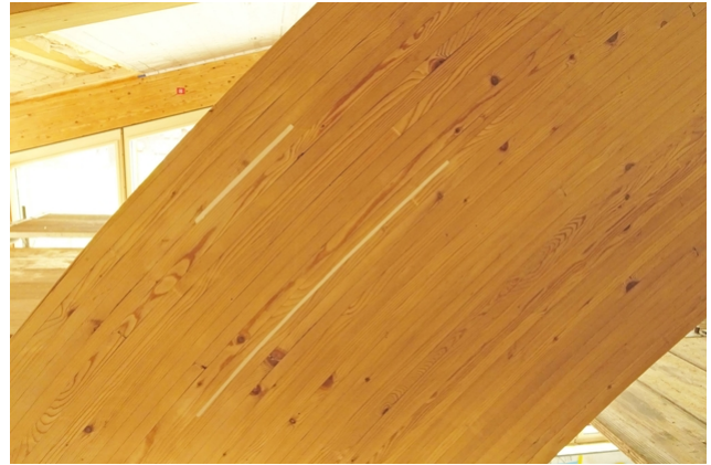
Detailansicht einer sanierten Klebstoffuge
