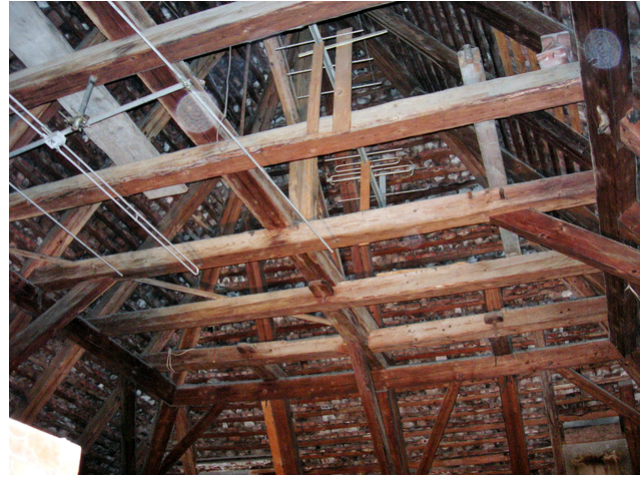
Dachgeschoss vor der Renovierung
