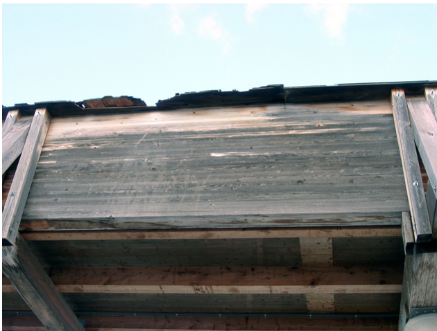
Fußgängerbrücke vor der Sanierung 2
