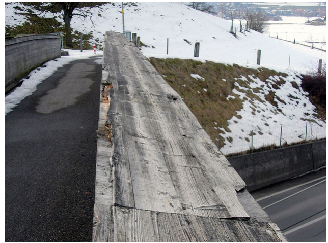
Fußgängerbrücke vor der Sanierung 1
