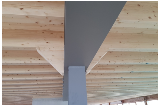
Kombination von Stahltragwerk und Holzbau
