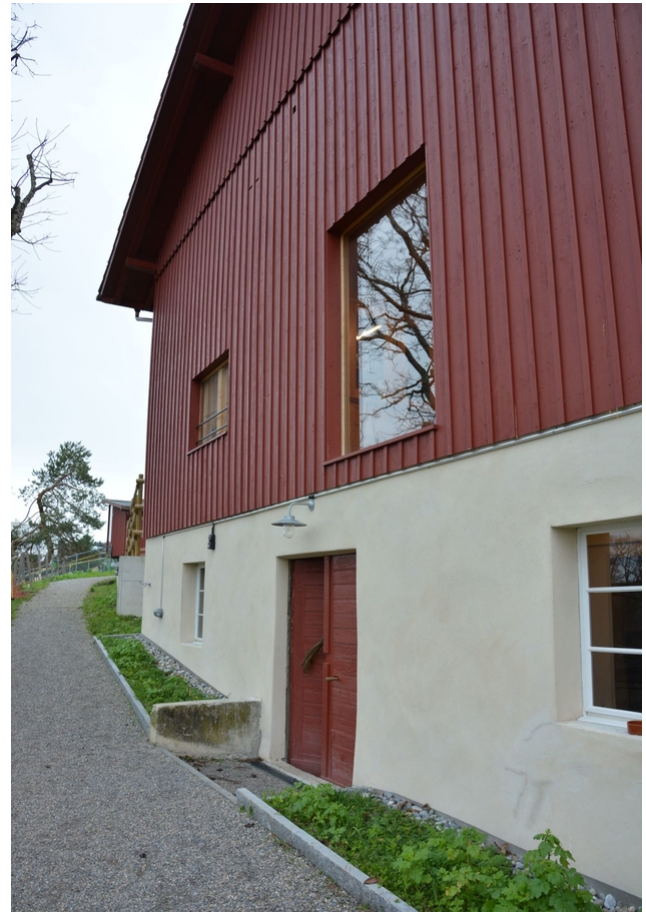
Rot gestrichene Fassade
