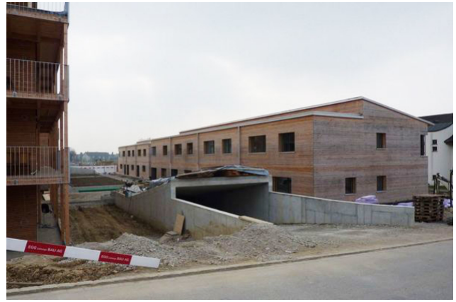
Eingang zur Tiefgarage
