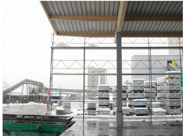
Stahlstütze und Holzbinder
