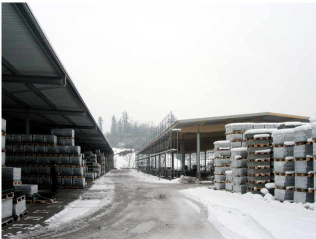
Alte und neue Überdachung
