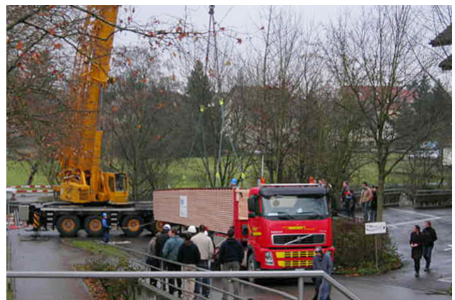
Montage vom Lkw aus
