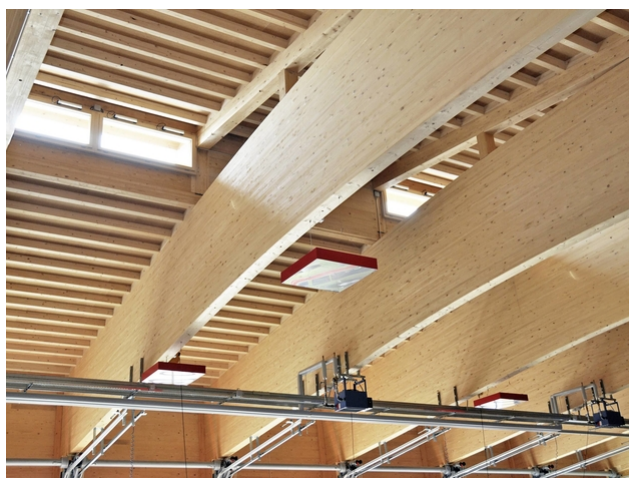
Detailaufnahme der grossen und schweren Holz-Bogenbinder
