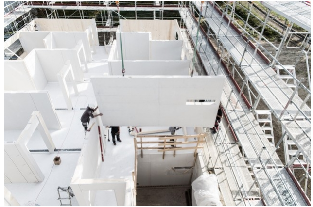
Montage der brandabschnittsbildenden Innenwände
