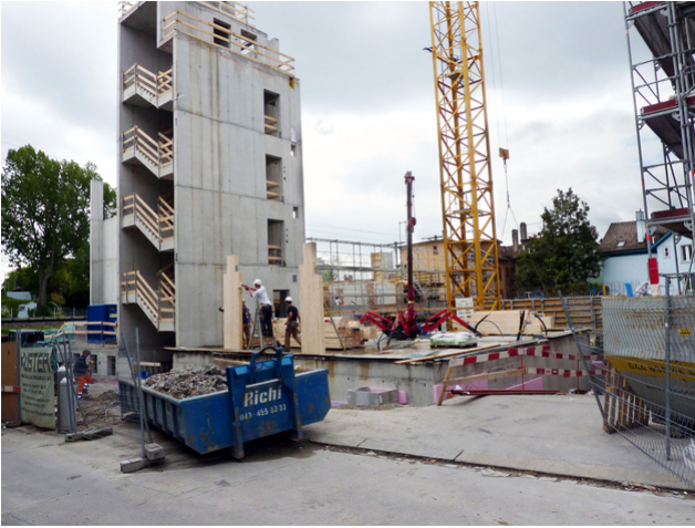
Start Stützenmontage EG
