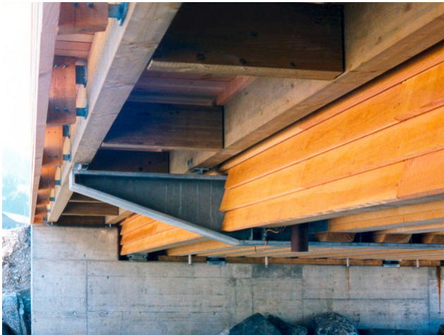
Eingebauter Stahlquerträger
