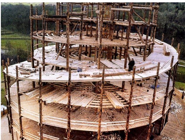
Turm im Rohbau
