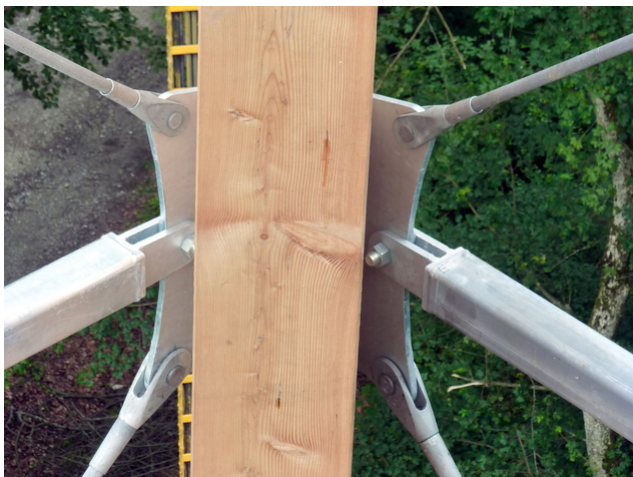
Zug- und Druckstangenanschluss
