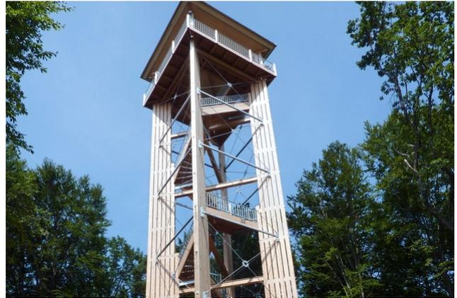
Erster Preis beim Projektwettbewerb Turm Altberg! Ein Holzturm mit palisadenähnlicher Stützenanordnung auf den Grundrissdiagonalen, einem sich nach oben öffnenden Treppenaufgang und überdachter Aussichtsplattform auf gut 30 m Höhe.
