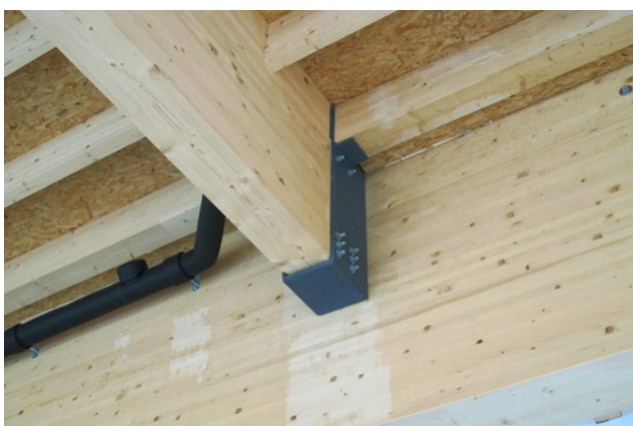
Dachstütze Detail
