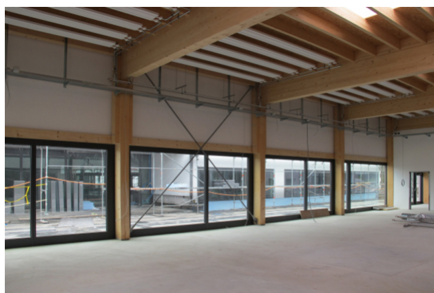
Innenansicht mit Glasfront
