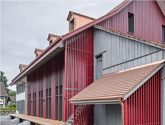
Die Holzschalung ist mit einer oxydrotten Öllasur gestrichen worden
