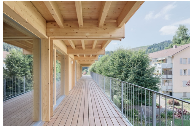
Auf den Laubengänge dienen dem Holzschutz und sind Aussenraum zugleich.
