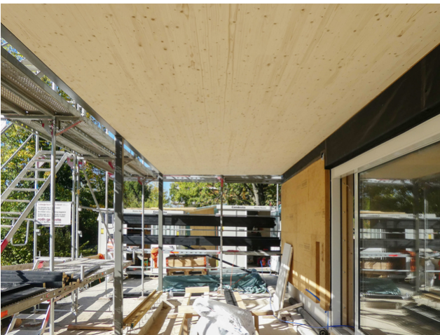
Eine der Holzterrassen während den Bauarbeiten
