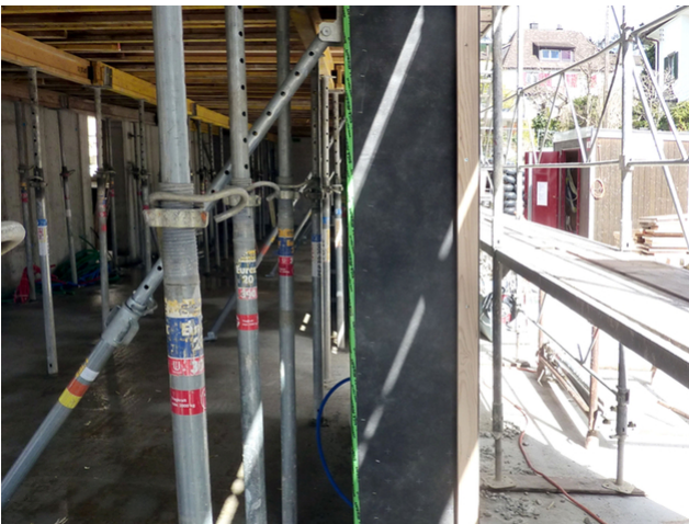
Tragende Holzwände EG vor dem betonieren der EG Decke
