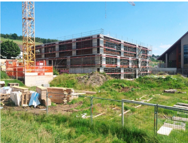
Kürzere Bauzeiten dank Holz (Bilder von Roger Frei)
