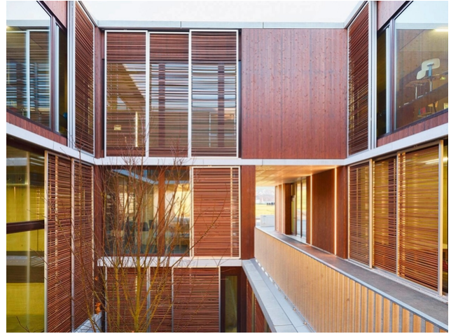
Blick in den Innenhof: Filigrane Holzschiebeelemente schützen vor der Sonne
