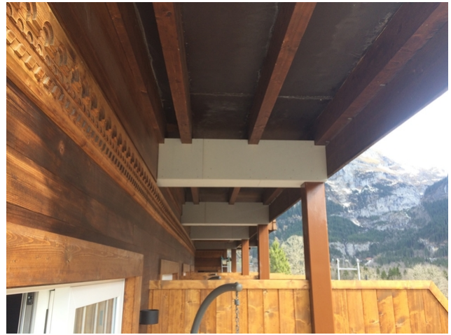
HEB Träger verkleidet
