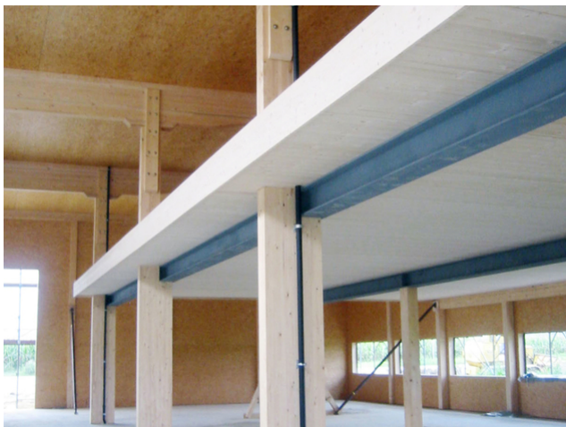
Galerie mit 1t Nutzlast pro m2
