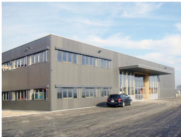
Gebäudeschmalseite mit 3m Vordach
