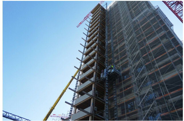
Gerüsteturm von unten
