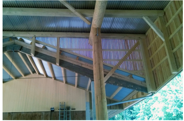
Tragwerk im fertigen Gebäude
