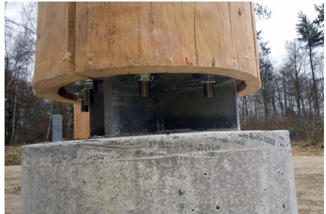
Montierter Stützenfuss
