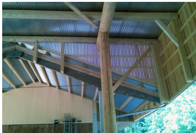
Tragwerk im fertigen Gebäude
