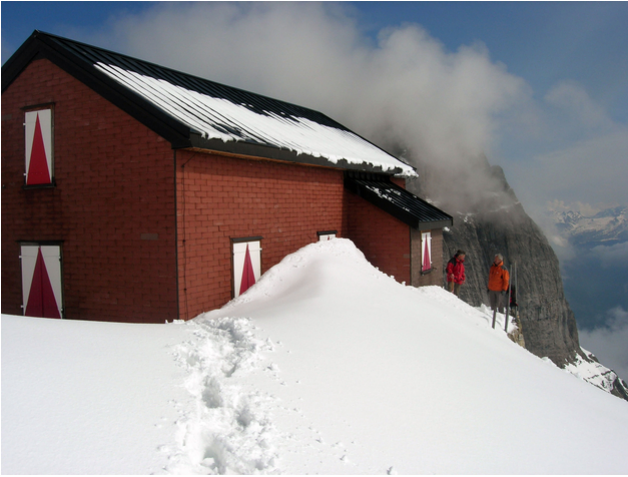
Die ursprüngliche Dossenhütte
