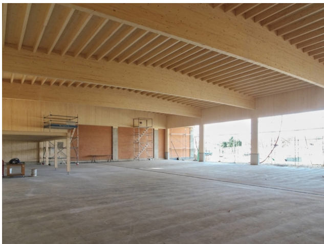
Blick nach innen: Die 25 Meter langen Traversen tragen das Hallendach
