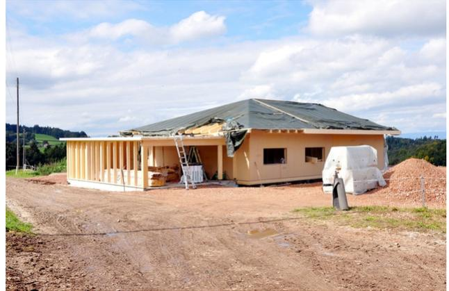
Das ländlich gelegene Einfamilienhaus wurde vollständig vorgefertigt und nach nur 4 Monaten Bauzeit war das Gebäude bezugsbereit. Der Holzbau birgt eine Weltneuheit – nämlich das von Timbatec entwickelte TS 3.0 – ein Deckensystem aus Platten, welche analog einer Betondecke 2-achsig tragen.
