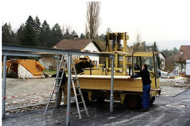
Den Architekten schwebte eine über zwei Stahlträger gelegte Holzplatte vor - mit Spannweite von 4.50 m. Die Platte sollte höchstens etwa 4 cm dick und mit einer Begrünung versehen sein. So nicht ausführbar, denn mit einer Konstruktion unter 110 mm Dicke wäre die Durchbiegung zu gross geworden. Eine solche Stärke wäre aber weder ästhetisch noch wirtschaftlich befriedigend gewesen.
