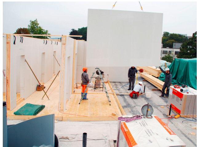
Versetzung Trennwände Aufstockung
