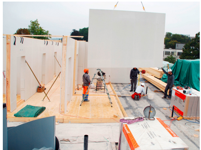
Versetzung Trennwände Aufstockung
