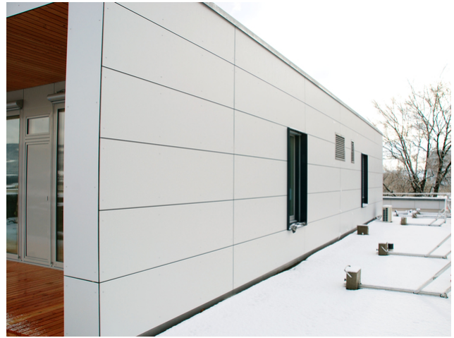
Fassadenansicht Aufstockung Ostseite
