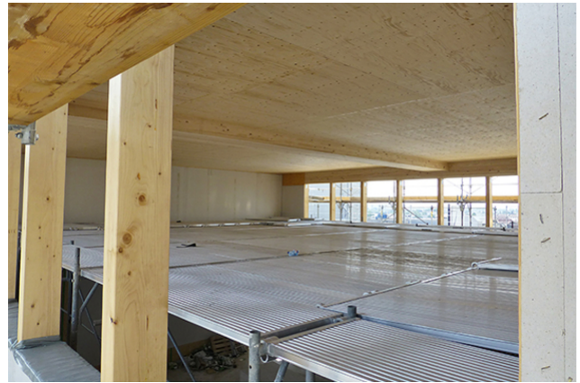
Deckenatrium mit 12m Spannweite
