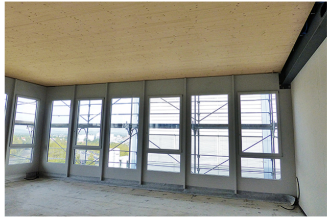
Holzdecke mit 9m Spannweite
