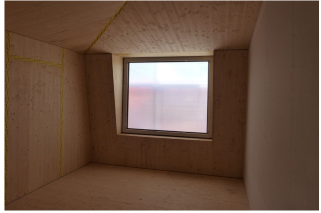
Innenansicht während der Bauphase
