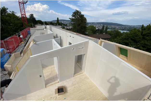
Ansicht direkt in den Elementbau Aufstockung
