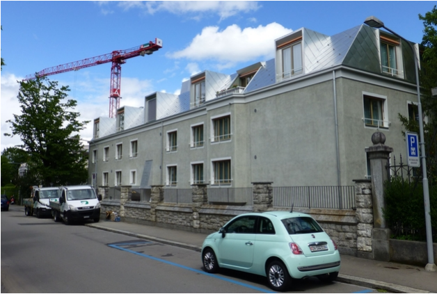
Aussenansicht im fertigen Zustand
