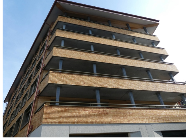
Appartementshaus Wolf: Bedeckt mit Holzschindeln von oben nach unten
