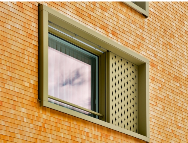
Im Detail: Teil der Lärchenholzfassade
