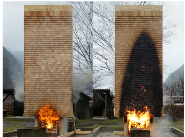
Ein Brandversuch der Schindelfassade
