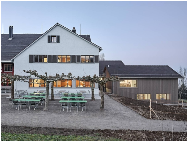
Rechtes Bild: Das von Timbatec geplante neue Holzgebäude
