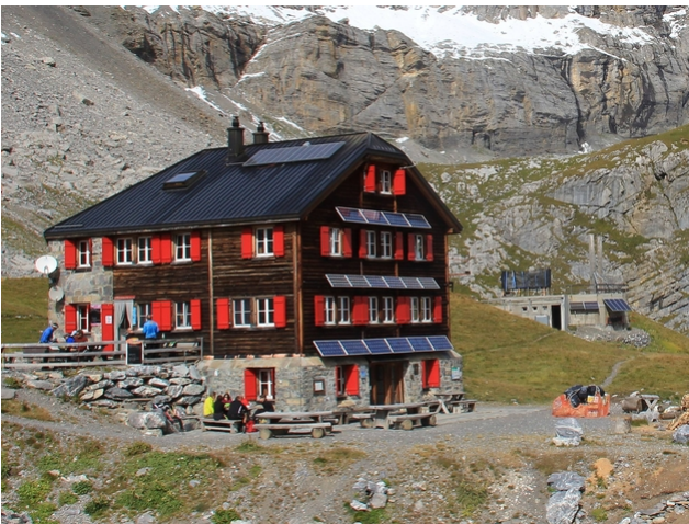
The Lämmeren hut before the extension
