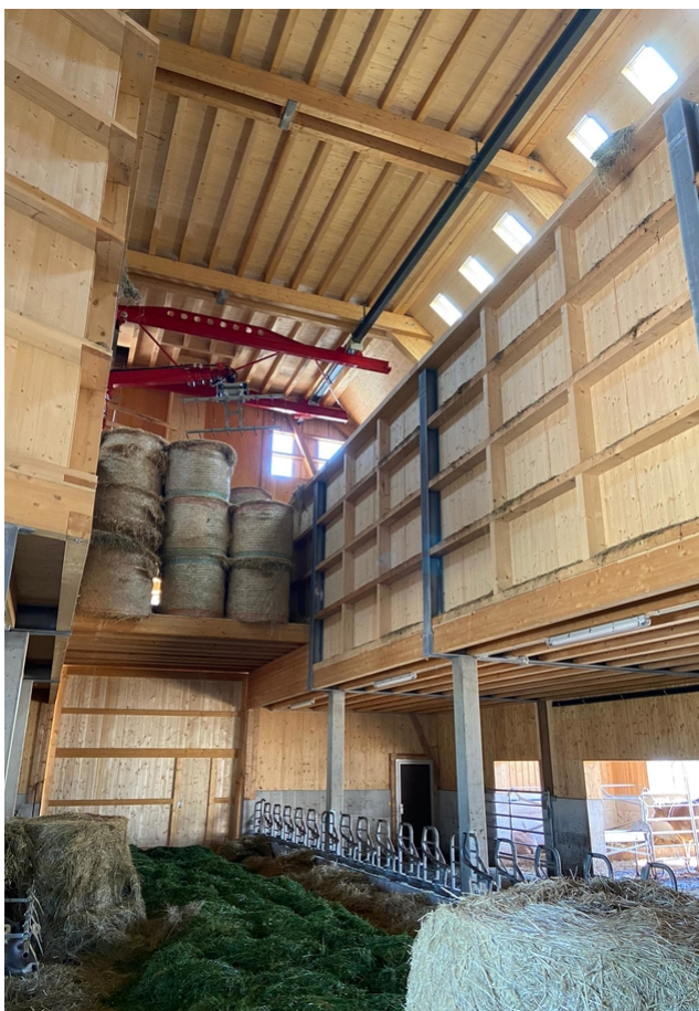
Suspension de la grue à foin dans la grange
