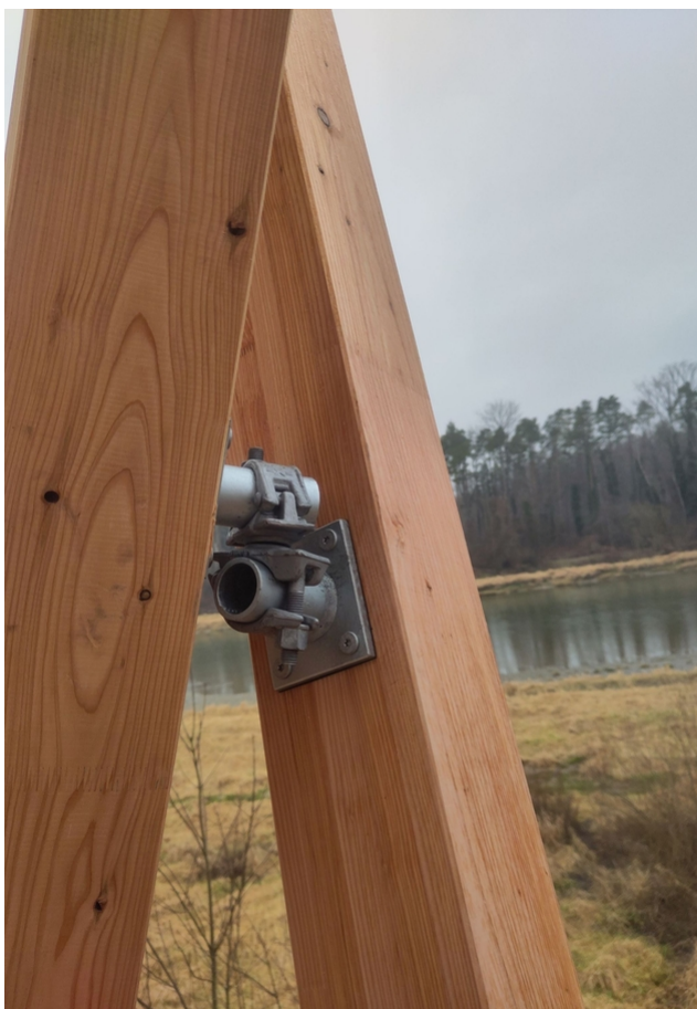
Assemblage des barreaux
