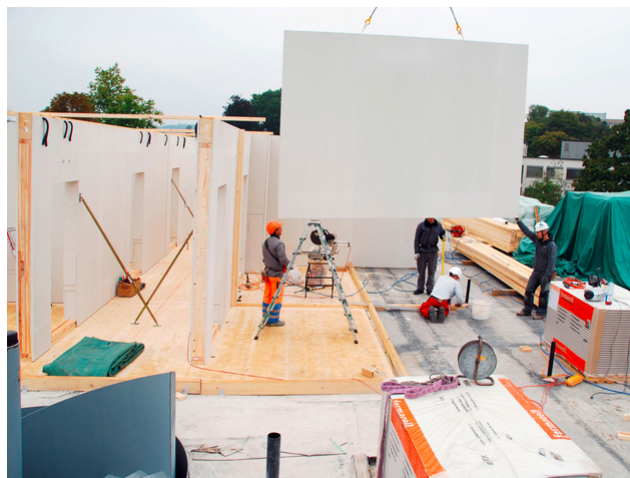
Déplacement de cloisons Rehaussement
