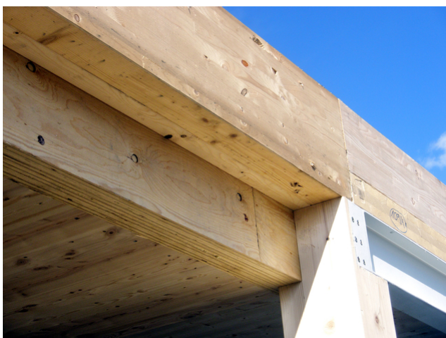
Linteau de fenêtre
