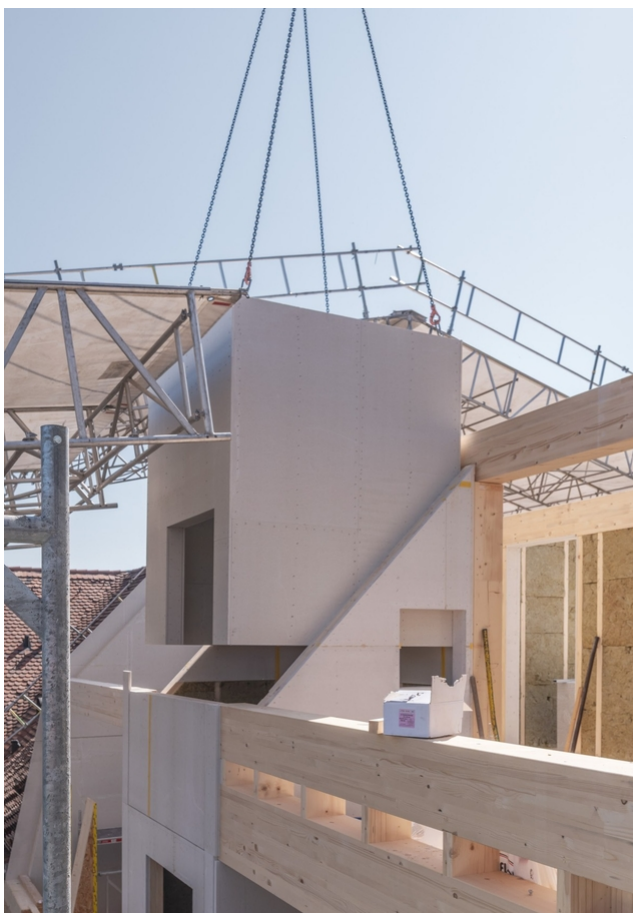
Des modules préfabriqués sont installés sur le chantier.
